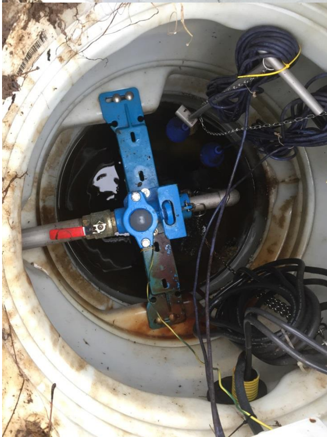
Bild 1. Gemensam pumpstation för avloppsförening med LTA system (LTA =Lätt Trycksatt Avlopp)
