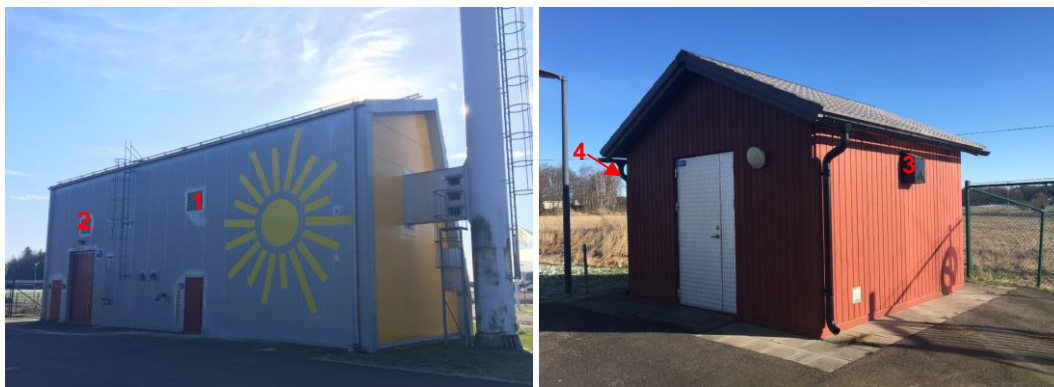
Befintlig panncentral och pumphus med ljudkällor markerade med rött.
